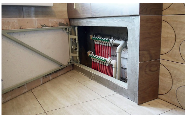
trappe DISCRET dissimulant un collecteur pour plancher chauffant
